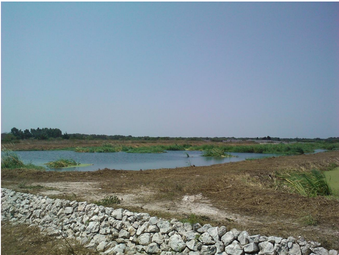
Foto: Impianto di fitodepurazione di Melendugno
